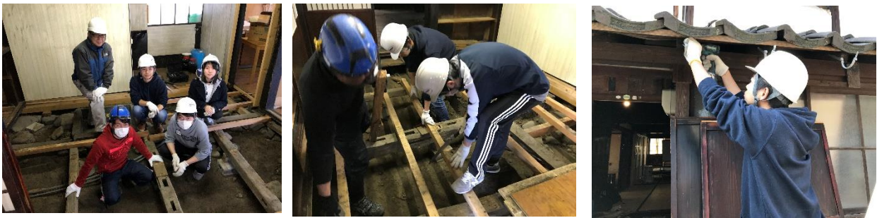
図8 床の張替え工事と外部の補修
